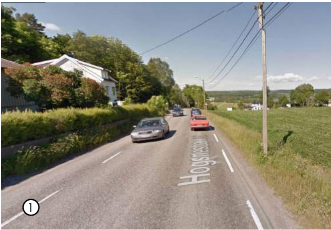
Manglende tilrettelegging for gående og syklende i Hogsnesbakken.
